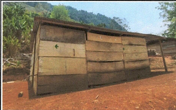
Foto 2: MEJORAMIENTO DE PAREDES DE MODULOS
